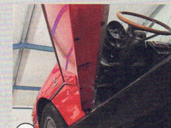
4 Ein Umlenkrollen-Halteblech im Innern der Türen lässt die Böden mittig durchfaulen
